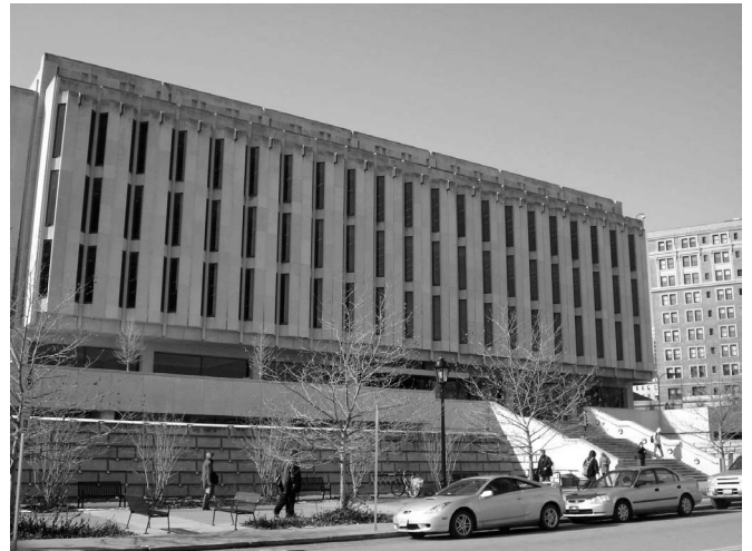
Hillman Libraryの外観
